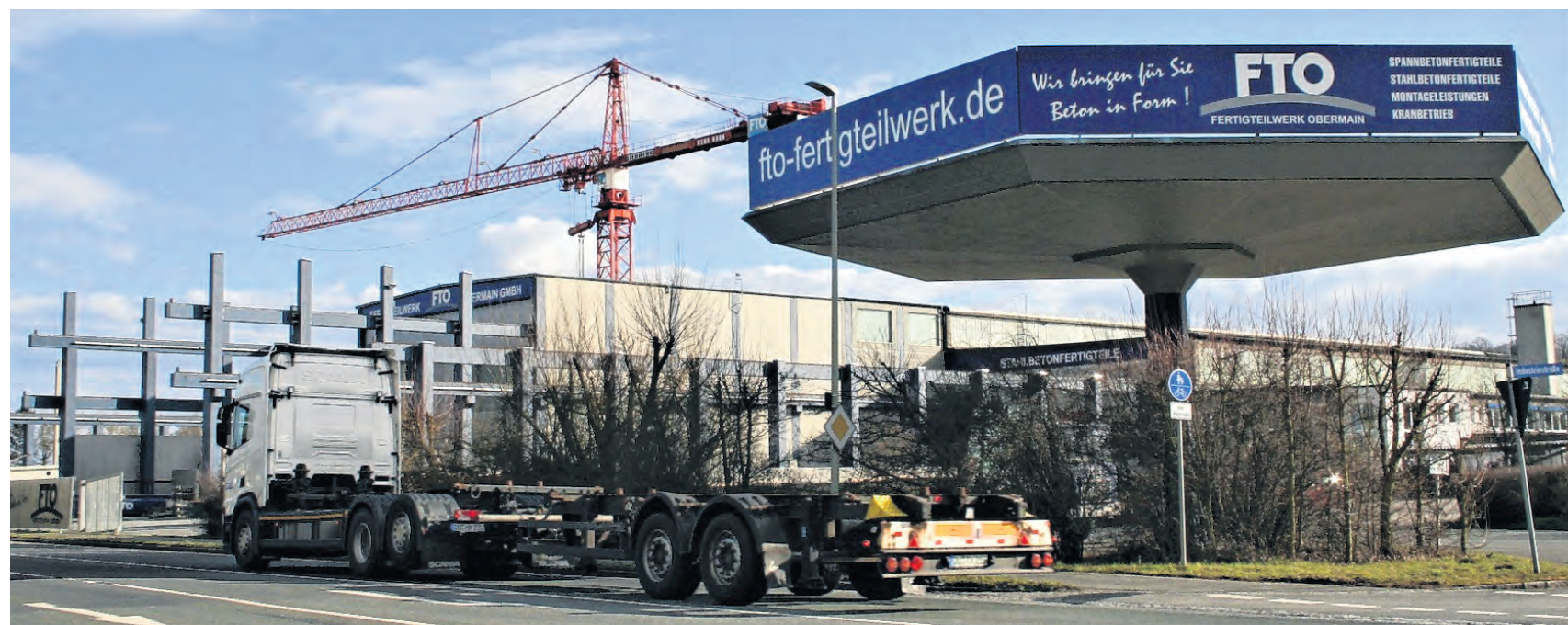
Das Fertigteilewerk Obermain gehört seit Jahresbeginn zur polnischen Pekabex-Gruppe.
