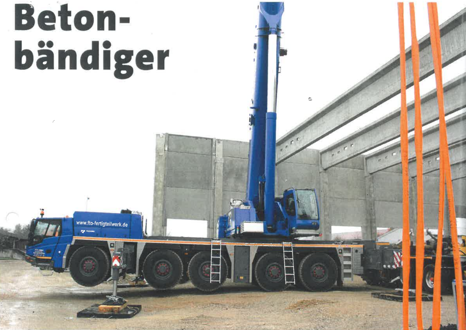
Während der Arbeiten musste der ATF 220G-5 nicht umgesetzt werden.
