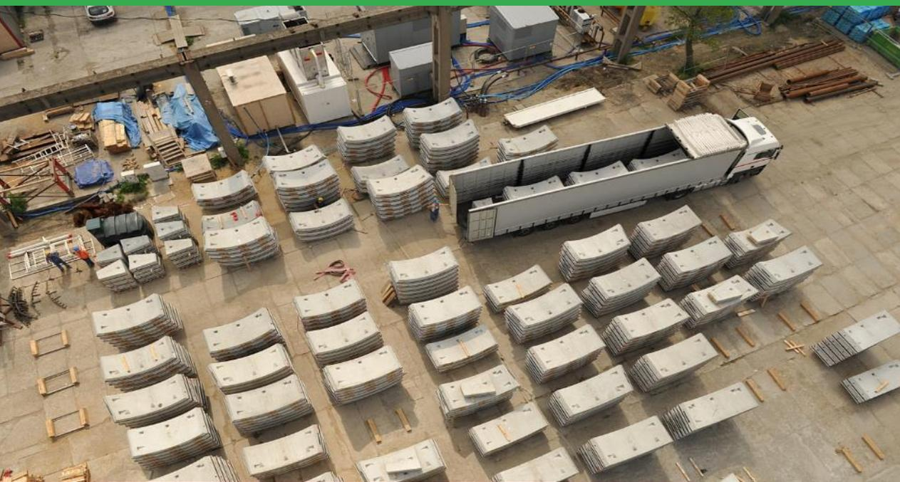
Teile für unterirdischen zylindrischer Tunnelbau
